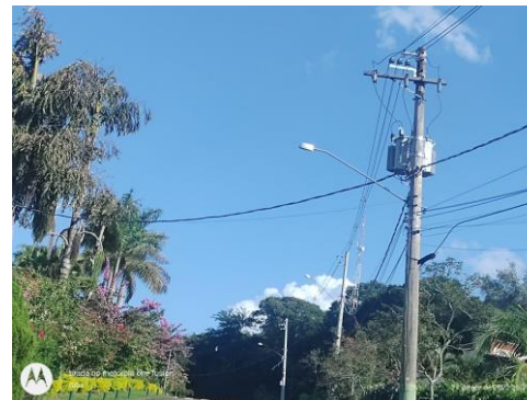
Substituição da rede convencional por compacta (space cable)
