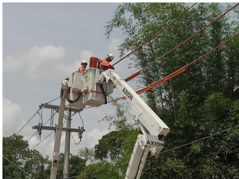
Coberturas de proteção
